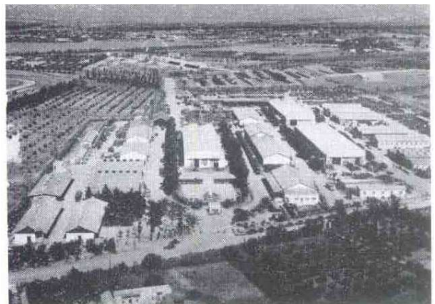
KASSAR-SAÏD : Un aspect de l'évacuation, avant...
