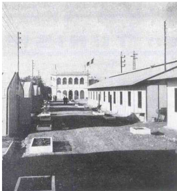
KASSAR-SAÏD: Installations de la compagnie de réparation
